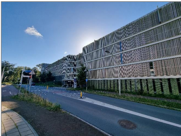
Afbeelding 1.3 | Parkeergarage aan de Stationsweg.
